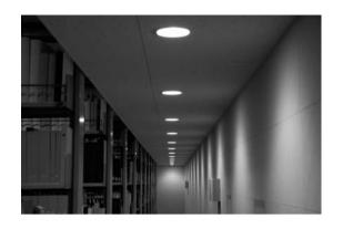
に保存書庫内ではできる限り資料が光にさらされ ないよう配慮している。センター開設時には書庫 内に窓があったが、10年程前に撤去工事を行った。 書庫内の照明は2年前の改修時に、蛍光灯(紫外 線除去フィルム付)からLEDに変更した。LEDは 光線段階で紫外線をカットできる上、蛍光灯に較 べて寿命が約4倍、消費電力が約半分で、ランニ ングコストを抑えることができる。また、熱を発 さないこともメリットのひとつである。ただし、 LEDは導入時のコストが高く、また採用したタ イプは寿命が来た際にユニットごと交換する必要 があるため、交換時のコストも嵩む。また、現在 商品化されている一般的なLEDは演色性の低い ものが多いため、光線下で資料を見たときに不自 然な色合いに見える場合があることに注意が必要 であろう。1Fの閲覧スペース、事務スペースに は窓があるが、紫外線除夫フィルムによって99% 以上の紫外線がカットされている。
