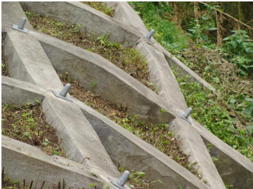
図 7 調査フィールドで初期に施工されたフリーフレーム工法の状態（写真）
