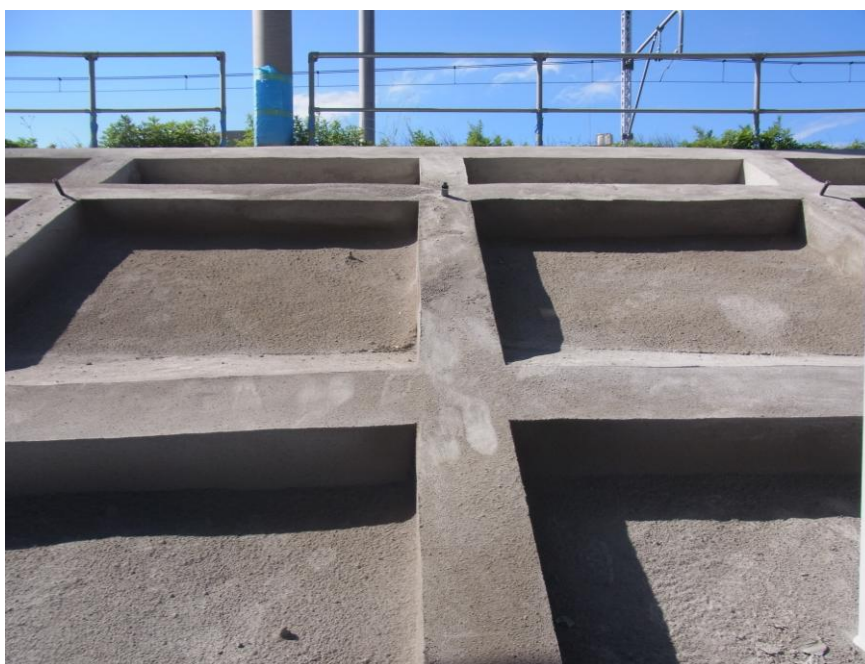
図 1 フリーフレーム工法の施工後の状態（写真）
