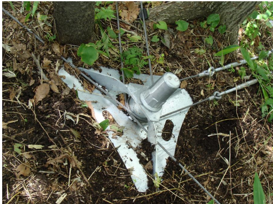
図 2 ノンフレーム工法の施工後の状態 (写真)
