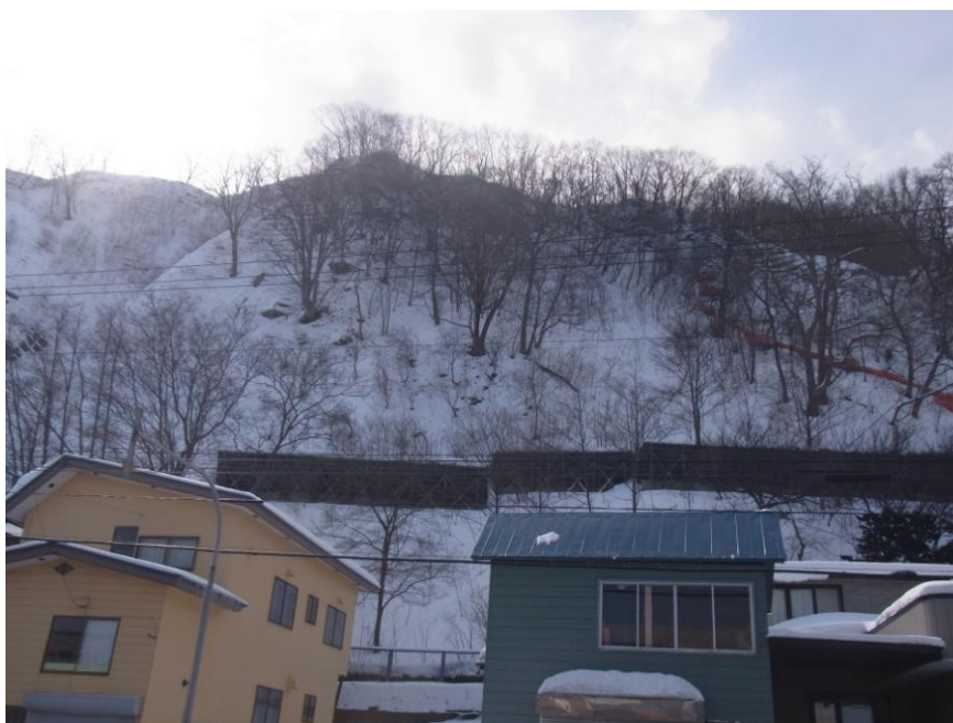
図 5 北海道 伊予部地先災害関連緊急治山工事 函館市木直町（旧南茅部町）現場の状況（写真）
