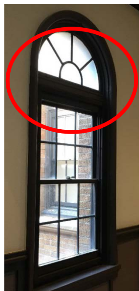
図4 内倒し窓（赤丸が鳩の侵入経路）
