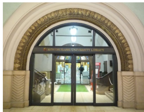
時計台棟から図書館本館入口を見る
